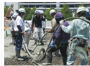
↓現場での施工風景
